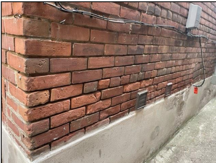
Spalling
